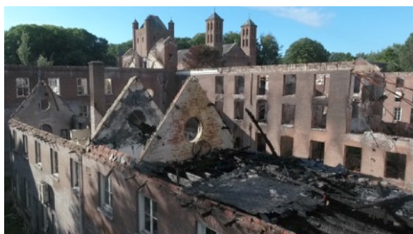
Snel en veilig overzicht en inspectie na bv een brand
